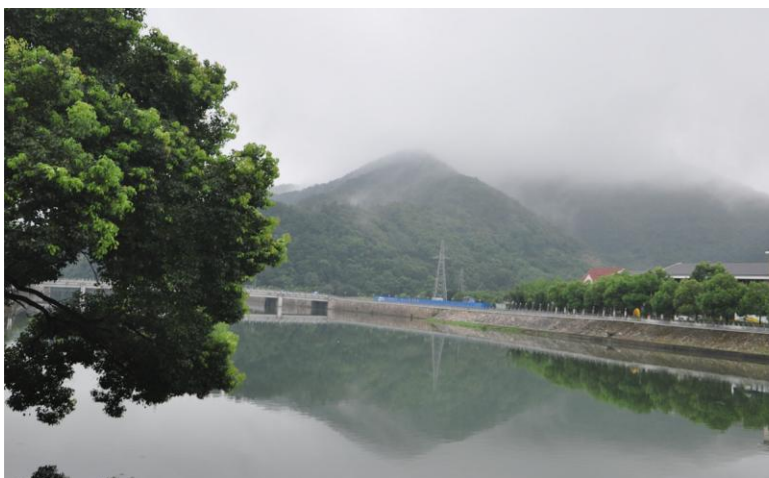
宁波慈城古县城海绵城市综合整治工程
