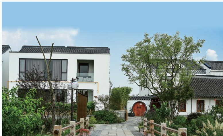
上海浦东新区农村污水管网改造工程
