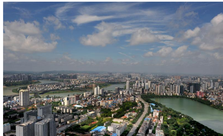
广西南宁雨污综合改造提升工程
